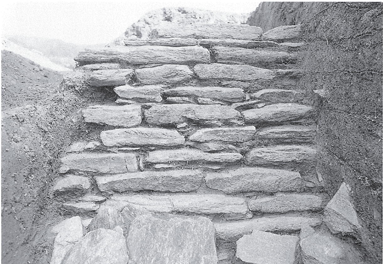
階段状石積（北西から）
