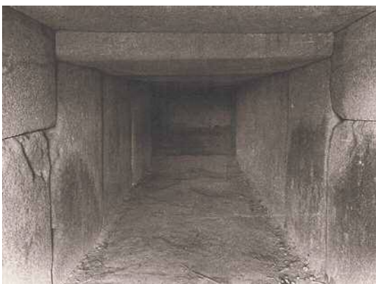
写真8 ゴーランドが撮影した岩屋山古墳
