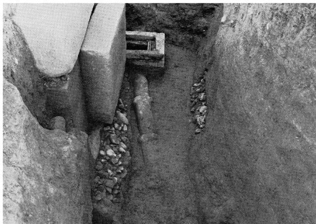
写真 3-2 昭和11年に設置された排水管
