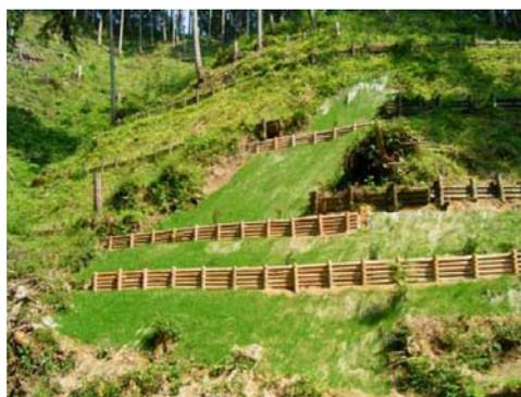
スギ・ヒノキの間伐材を利用した丸太柵工（大阪府河内長野市）
