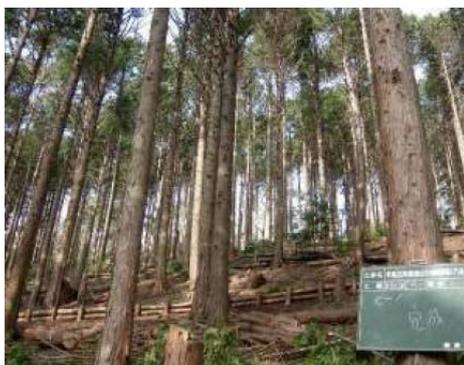
現地の本数調整伐で発生したスギ材を利用した林内の丸太筋工（静岡県伊東市）
