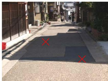
地下埋設工事に伴う舗装の復旧や舗装の維持補修においては、従前の舗装と同一又は類似の舗装材料の採用
