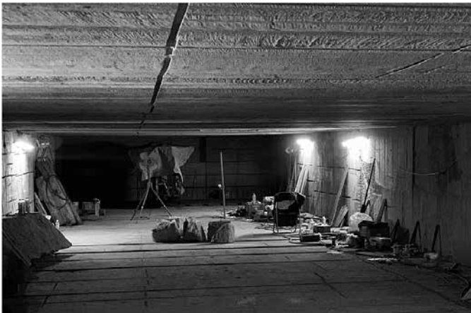
牽牛子塚古墳に使用された石材の採掘地点の様子
