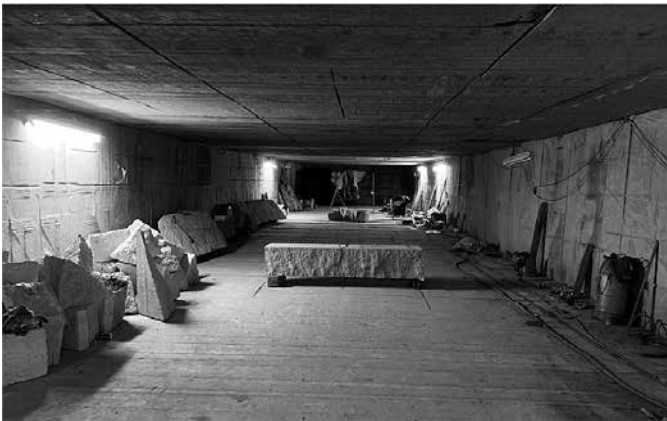
坑道内の様子
