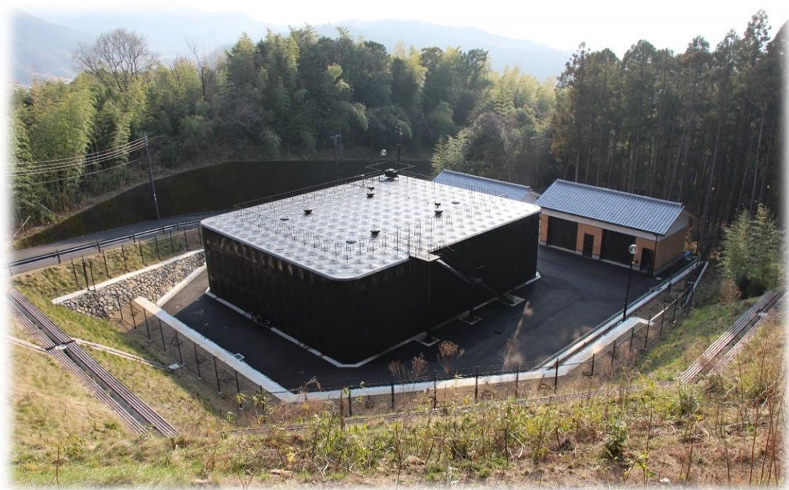
明日香村配水池
